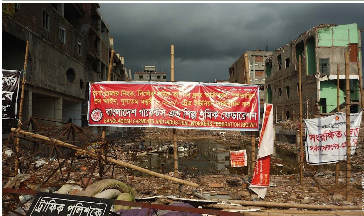
Eine Fabrik des Rana Plaza Komplexes war kurz vor dem Einsturz auditiert worden, aber dadurch konnte die Katastrophe nicht verhindert werden.
