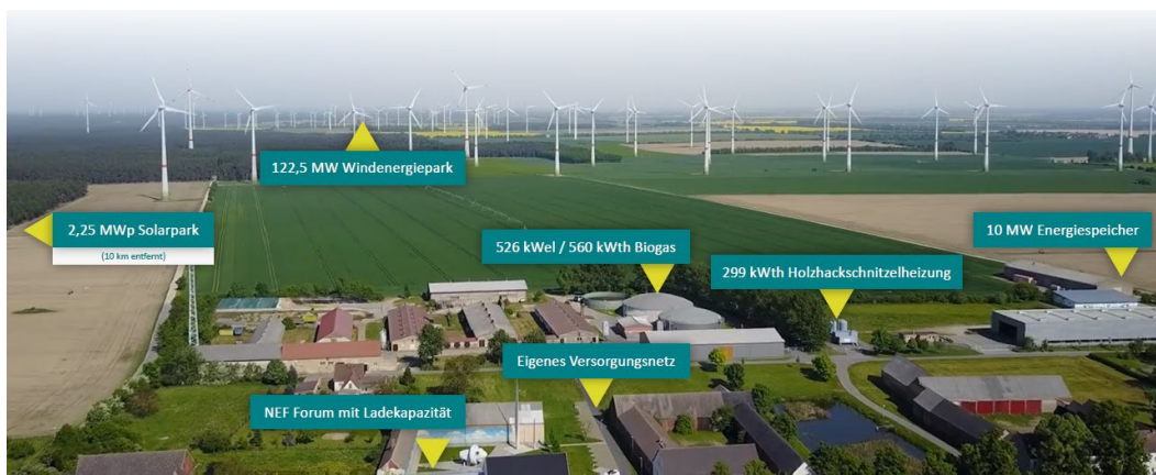
Das energieautarke Dorf Feldheim; © Energiequelle GmbH
