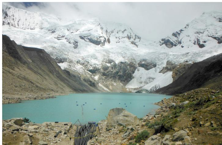
El lago glaciar Palcacocha con un sistema de descarga de bombas improvisado en primer plano, que no es suficiente para evitar un peligroso aluvión.
