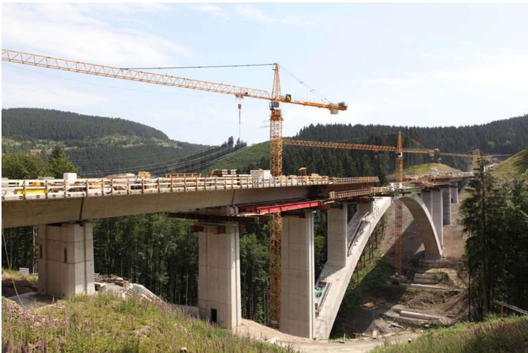
Abb. 2: Je nach Topographie kann der Bau von HGS sehr aufwendig sein und hohe Kosten verursachen. Hier zu sehen: Arbeiten an der Dunkeltalbrücke für die NBS Nürnberg-Erfurt im Juli 2012 in Thüringen. (Foto: Störfix, Wikimedia Commons)
