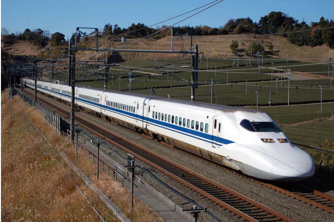
Abb. 4: Der japanische Shinkansen – Inbegriff für ein perfekt durchgeplantes HGV-System. (hier Shinkansen der Baureihe 700 zwischen Tokyo und Osaka) (Foto: Sui-setz, Wikimedia Commons)
