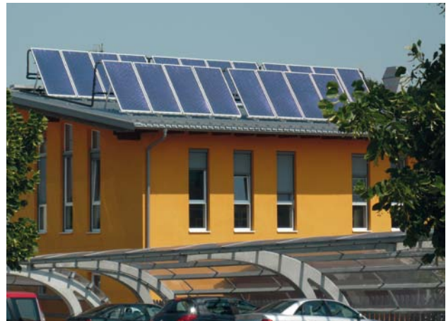
Solarthermische Anlagen verringern in immer mehr Häusern den fossilen Energiebedarf für Warmwasser und Heizung. Foto: Dietmar Putscher
